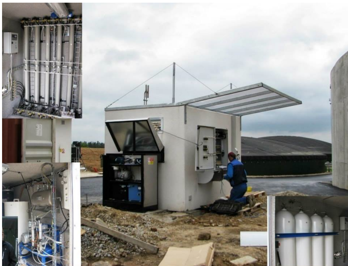
Obr. 12. Poloproduční jednotka s výkonem bioplynu 6 \text{ Nm}^3/\text{h} na agrofarmě Valečov postavená společnostmi IPRACZ s.r.o. a R-fin s.r.o. [D1]
