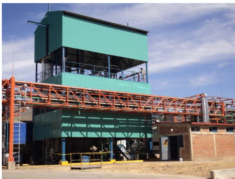
Obrázek 10 Jednotka na solidifikaci odpadní vody v závodě Huntsman, Atoto, Mexiko (fotoarchiv autora)
