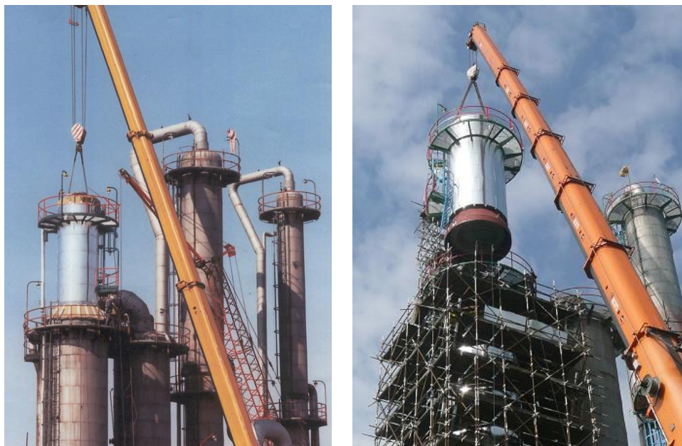
Obrázek 21 Rekonstrukce benzenové kolony ve společnosti DEZA, vlevo 1995, vpravo 2015 (fotoarchiv autora)
