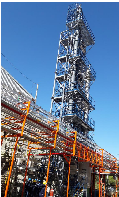
Obrázek 2 Extrakční a rektifikační kolona, firma Huntsman, Atoto, Mexiko (fotoarchiv autora).
