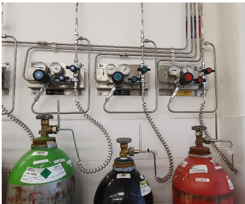
Obrázek č. 15: Redukční panel umístěný na stěně místnosti
